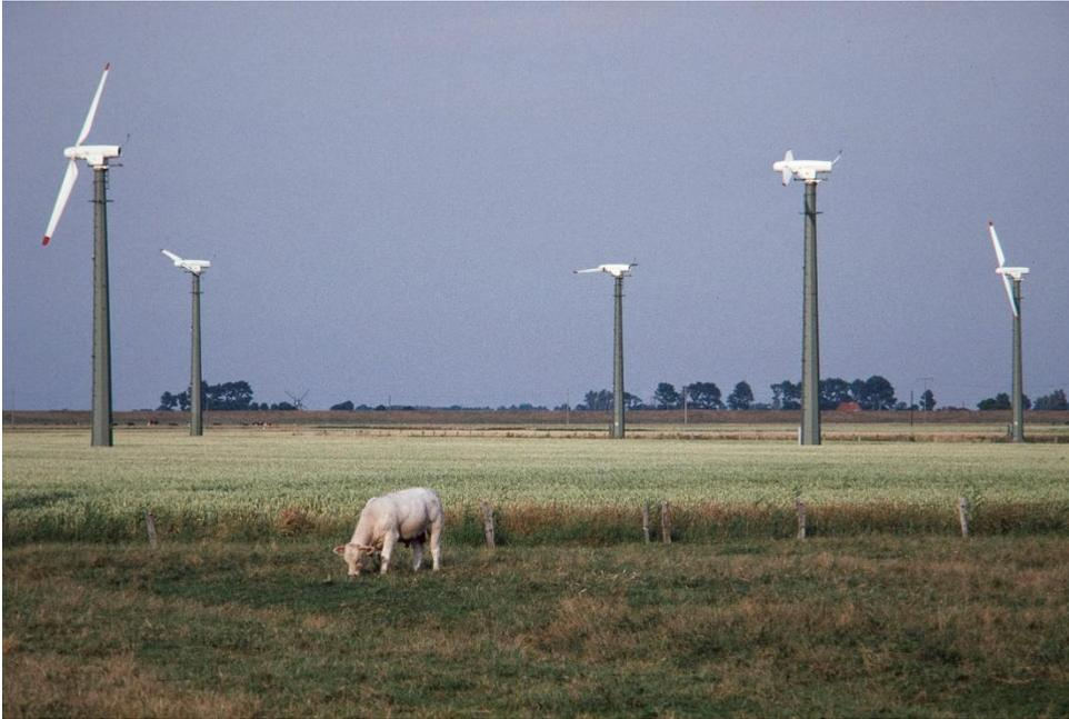
Keimzelle der Windenergieerzeugung: die Anlagen des Typs „Aeroman“ von MAN im Windenergiepark Westküste hatten eine Leistung von jeweils 55 kW. (Quelle: HanseWerk)
